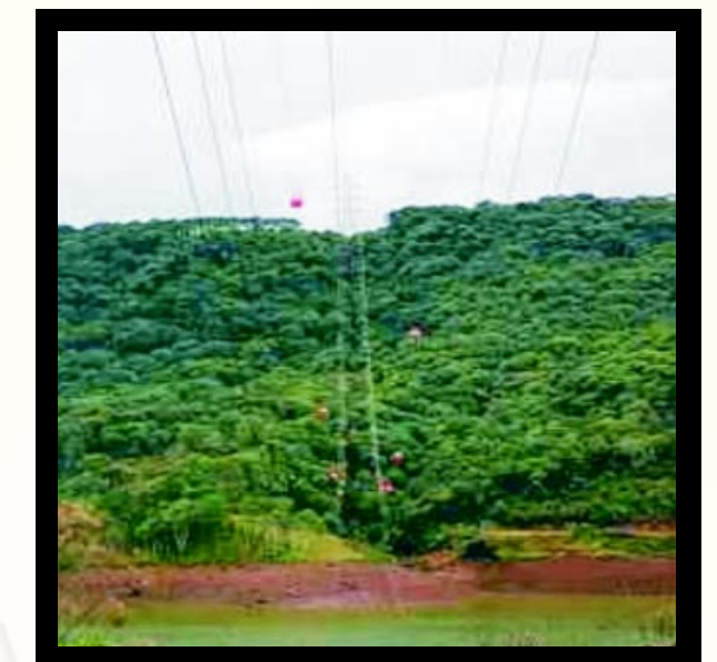
Cabo aéreo instalado em um vão de 1137 metros.
