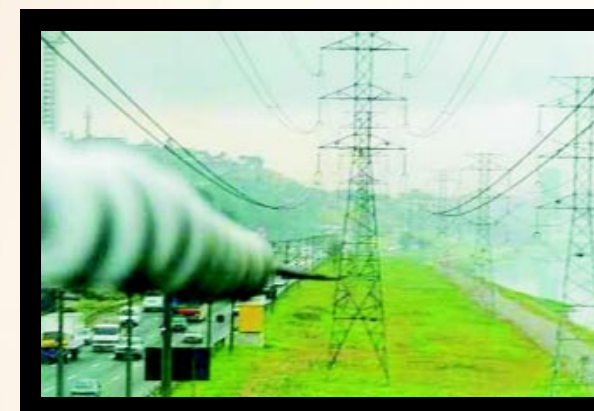
Cabo aéreo auto-sustentado em linhas de transmissão de 230 kV.
